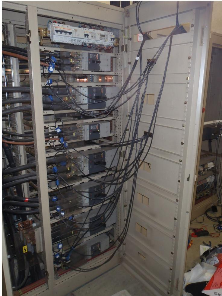
*Vue d'une des portes du TGBT avec les tores de mesure.*
